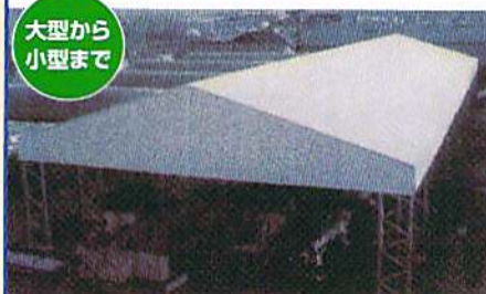
◎金沢木材協同組合 商業用テント工事 〇72m×25.4m 施工日(平成)13年2月
